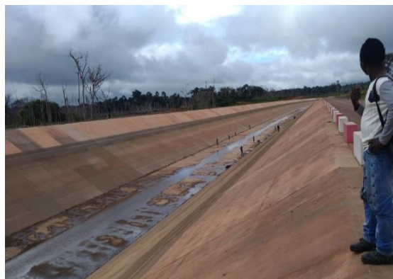
Canal d'amenée après vidange de l'eau
